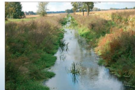
Ten sam odcinek, zarosnięty makrofitami, we wrześniu 2012 r. Przy tak zawężonej szerokości i takim wyprofilowaniu koryta rzeki, nie ma ona szans na wykształcenie naturalnego profilu cieku gwarantującego odpływ wody i naturalną strukturę brzegów.
