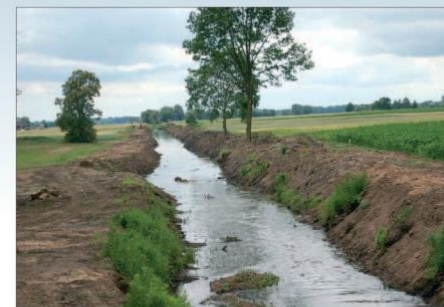
Prace „utrzymanio” na Stobrawie w okolicy Falków, czerwiec 2011 r.
